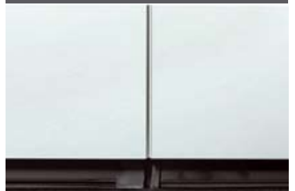
Dichtleisten zu Boden und Decke
